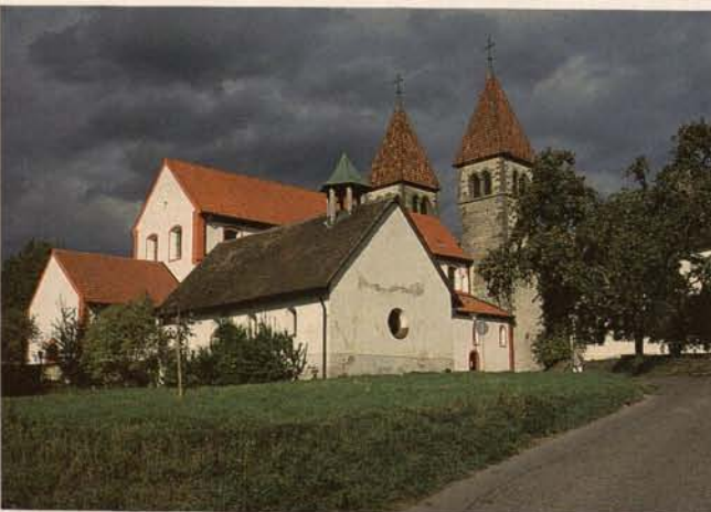
Abb. 1. Reichenau-Niederzell, Kirche St. Peter und Paul mit dem für die Einrichtung des Dokumentationsraums vorgesehenen Pfarrtorkel von Südwesten.
