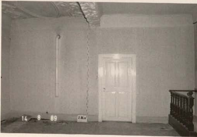
Abb. 12. Fürth, Königstraße 89, zweites Obergeschoss, stuckierter Raum vor der Instandsetzung (1989).
