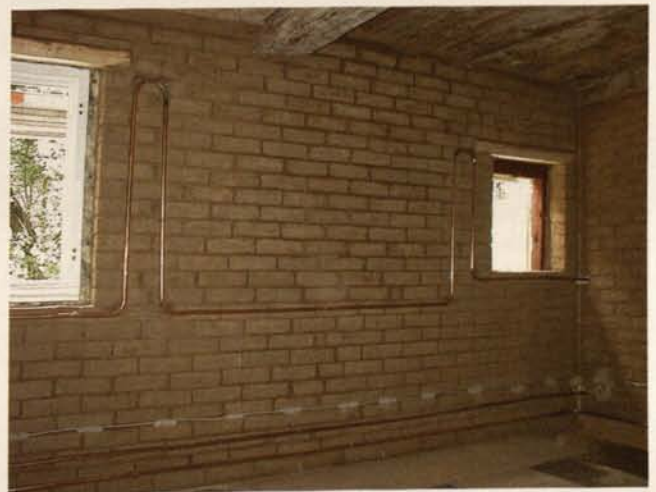
Abb. 24. Kucha, Haus Nr. 18, Mühlengebäude, Obergeschoss: Vormauerung mit Lehmstein vor der Putzausführung, mit aufgelegten Rohrtrassen der Temperierung und Elektroinstallation (2002).
