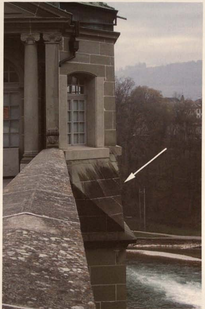
Abb. 12. Bern, Südwestecke der Münsterplattform, Pavillon (15.4.2004): 1987 gefestigte und hydrophobierte Fläche mit starkem Bewuchs, aber fehlendem Bewuchs dort, wo das auftreffende Wasser giftige Kupferanteile enthält, die sich als Grünspan niederschlagen.
