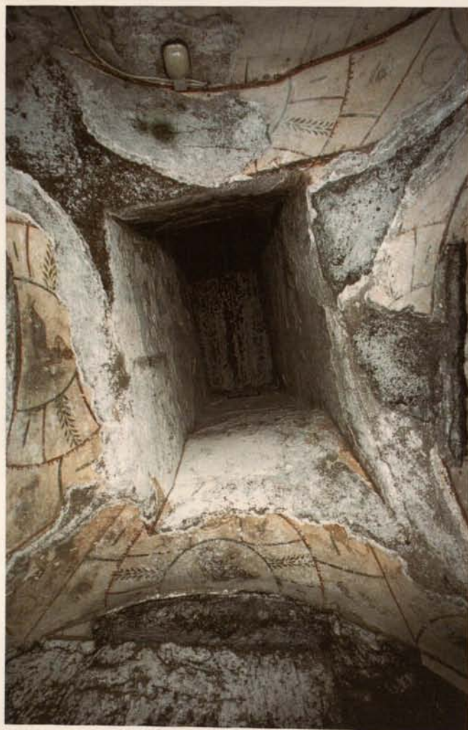
Fig. 7. Roma, catacombe di S. Callisto, cubicolo delle stagioni, volta e lucernario aggrediti da varie tipologie di attacchi biologici / Rom, Calixtus-Katakombe, Kammer der Jahreszeiten, Gewölbe und Lichtschacht mit verschiedenen Formen mikrobiologischer Besiedelung (1997).
