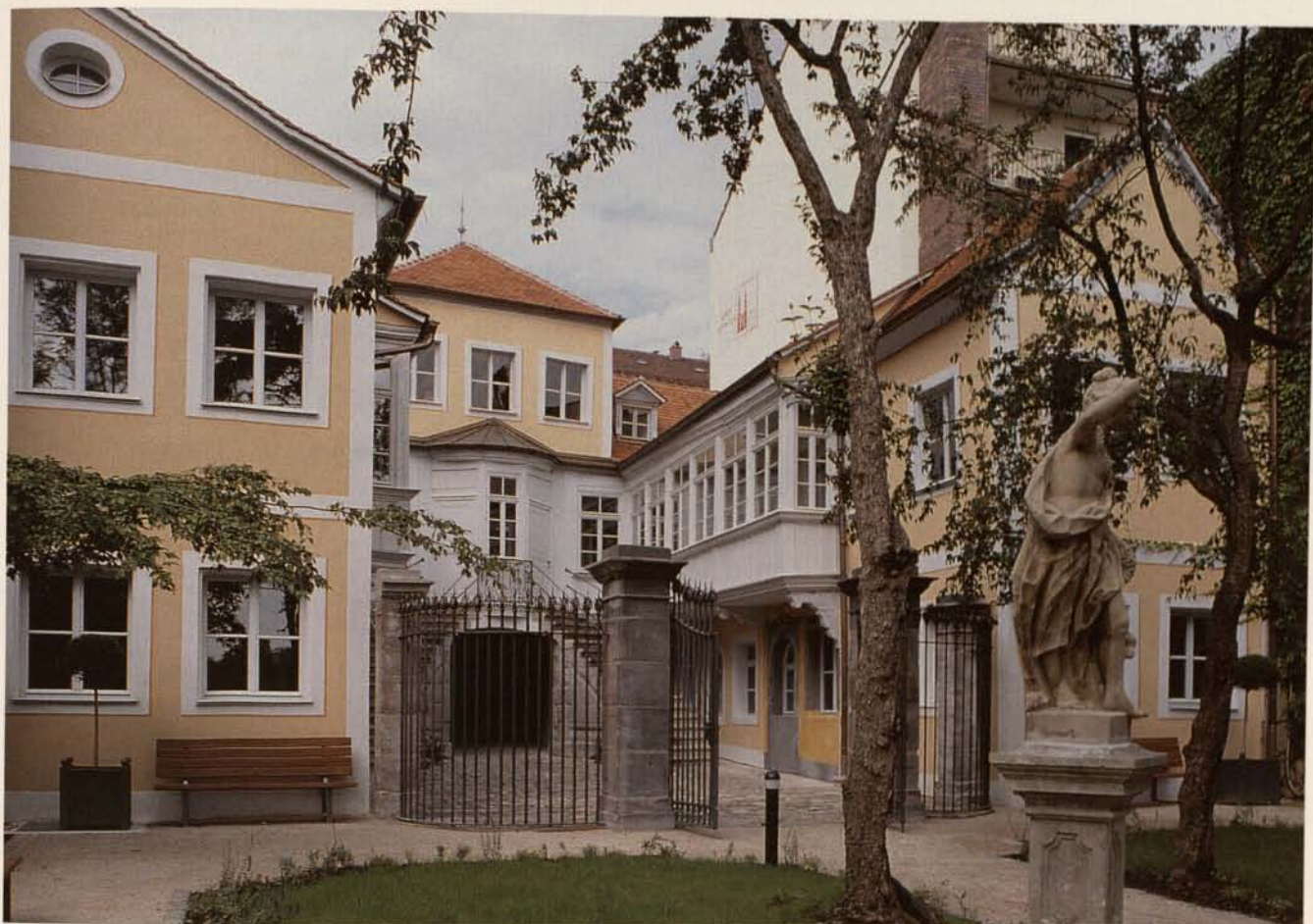
Abb. 4. Nürnberg, Johannesstraße 19, Südfassade mit West- und Ostflügel nach der Instandsetzung (2000).
