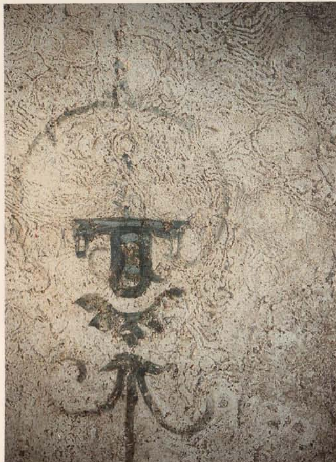
Fig. 6. Roma, catacombe di S. Callisto, cripte di Lucina, cubicolo y, fenomeno di alterazione dell'intonaco / Rom, Calixtus-Katakombe, Krypta der Lucina, Kammer y, Detail: Veränderungen der Putz-Matrix (2002).
