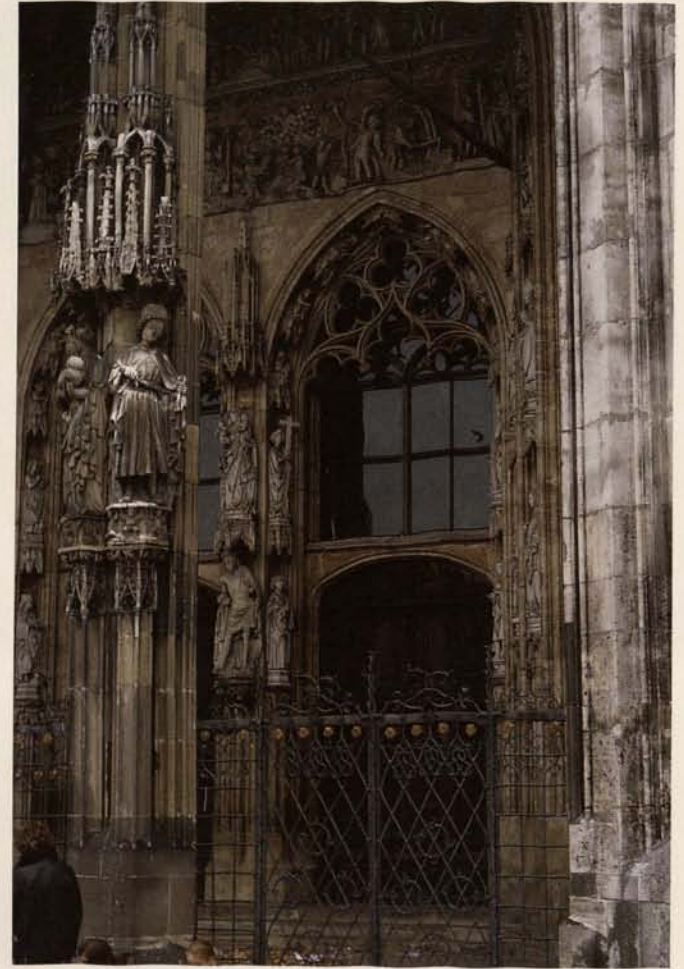
Abb. 11. Ulm, Münster, Westportalfenster: Einbau der neuen Schutzverglasung (2003).
