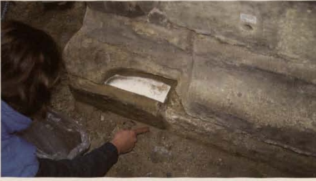
Abb. 13. Bad Wimpfen, Kreuzigungsgruppe von Hans Backoffen, Sockel: Substanzverlust beim Sägen.
