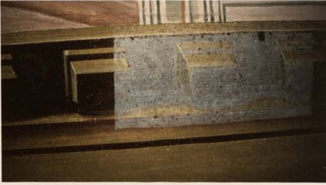
Fig. 1. Pommersfelden, Castle Weissenstein, the Marchini-rooms: Microbiological colonization of mural painting surfaces / Schloss Weissenstein, Marchini-Räume: Mikrobiologische Besiedelung von Wandmalereioberflächen.
