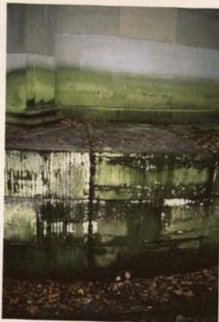
▷▷ Abb. 7. Iptingen, Huber'sches Mausoleum, Detail: Kalksinter-Fahnen an der Fassade infolge Dachundichtigkeit, da eindringendes Regenwasser das Calciumcarbonat aus dem Decken- und Wandputz gelöst und entlang der Putzrisse wieder ausgefällt hat.
