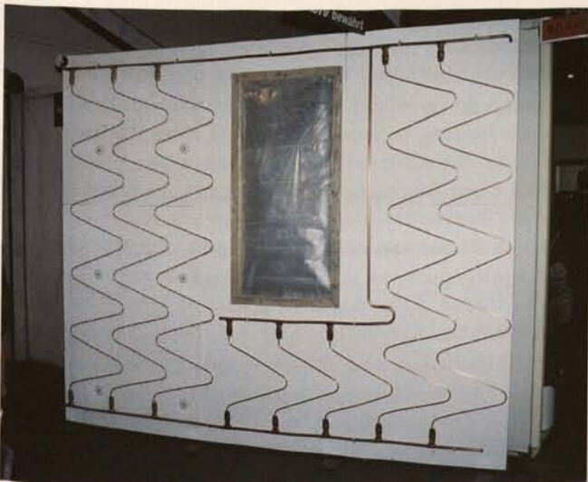
Abb. 10. Typisches Detail einer ausgereiften Wandflächenheizung: es entspricht fast in allem den bekannten üblichen Fußbodenheizsystemen.
