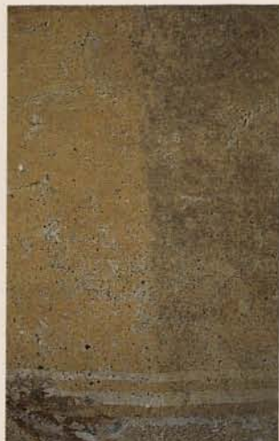
Abb. 7. Blaubeuren, ehemalige Klosterkirche, Hochaltar, Detail: Schimmelbildung auf einem Tafelbild wegen zu hoher Luftfeuchte im unbeheizten Kirchenraum.
