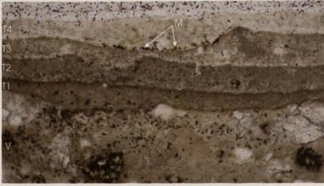
Abb. 7. Materialprobe eines Fassadenputzes mit Mikroorganismen im Dünnschliff (vgl. Abb. 6; aufgenommen 3 Jahre nach Herstellung des Dünnschliffs, weshalb die Mikroorganismen, ursprünglich kugelige, olivgrün-bräunliche Gebilde, nur noch als eingetrocknete Krümel sichtbar sind; V = Verputz; T1 bis T4 = Kalktüncheschichten, darüber Einbettungsharz mit Schleifstaub; M = Mikroorganismen; Aufnahme in einfach polarisiertem Licht, Bildbreite 0,6 mm).
