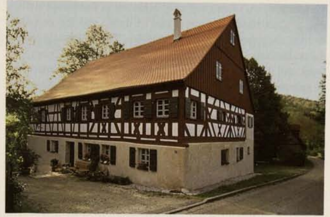
Abb. 22. Kucha, Haus Nr. 18, Mühlengebäude: Fassade nach der Instandsetzung (2003).
