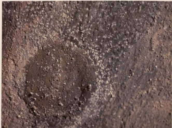
Abb. 9. Birnau, Klosterkirche, Deckengemälde, Detail: Besiedelung von Mikroorganismen auf einem mit Magermilch fixierten Fresko, nachdem hoher Besucherandrang und offen stehende Türen eine permanent zu hohe Luftfeuchtigkeit im Kirchenraum verursachen.
