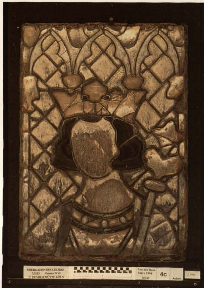
Abb. 8. Köln, Dom, Fenster nVI, Feld 4c, Detail: Korrosionsprodukte auf der Außenseite der Gläser (1994).
