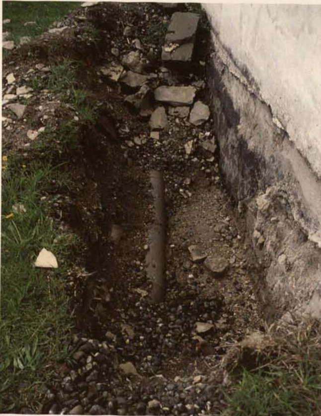
▷ Abb. 16. Schwäbisch Gmünd, katholische Kirche St. Leonhard, Außenansicht mit abgegrabener Aufschüttung (ca. 2m) und freigelegtem ehemaligem Sockel: grobkörniger Schilfsandstein mit hoher kapillarer Wasseraufnahme, die dunklen Zonen salz- und feuchtigkeitsbelastet.
