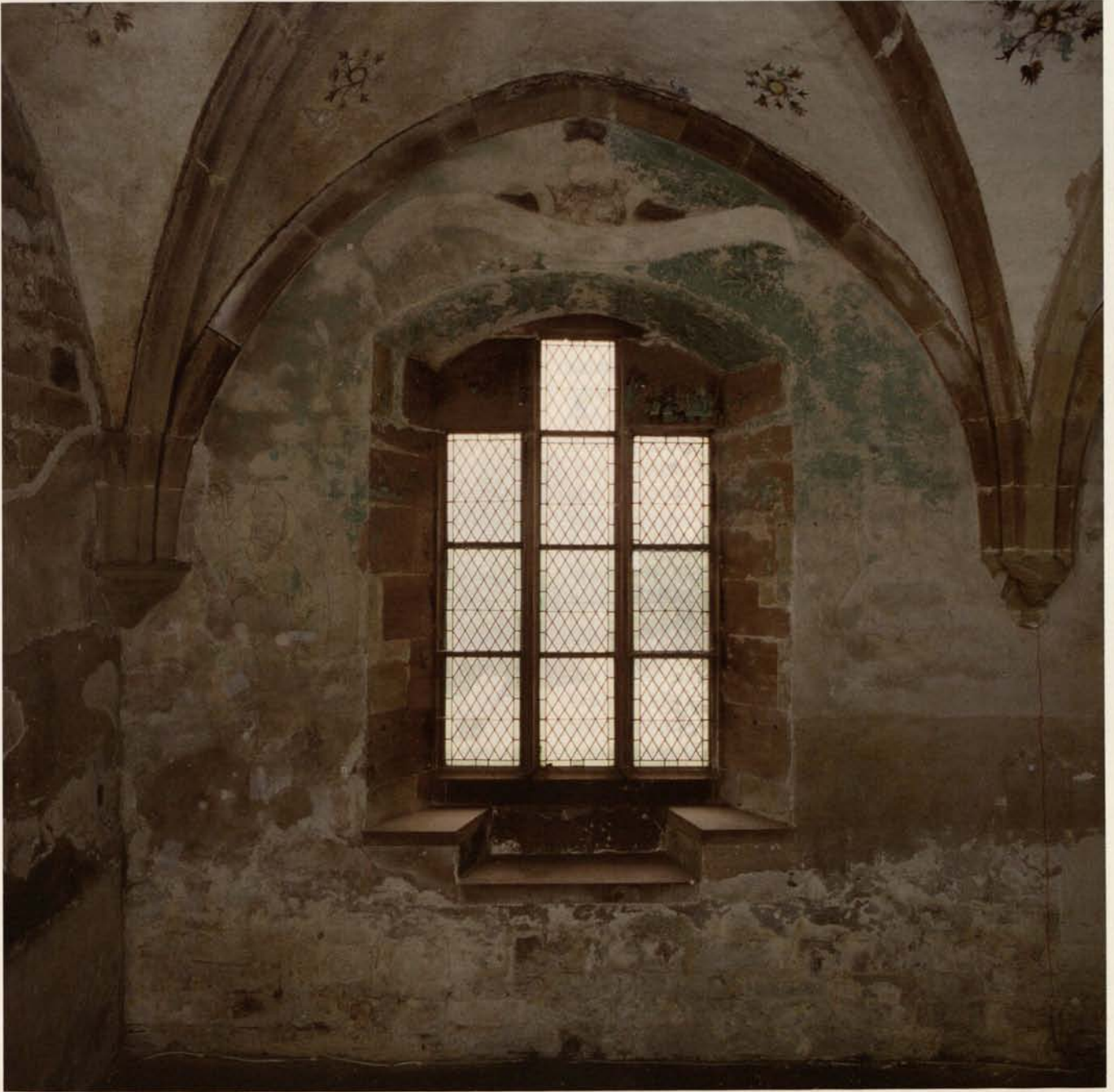
Abb. 3. Maulbronn, Kloster, Dormentbau, Laienrefektorium, Ostwand, nördliches Joch (1995).
