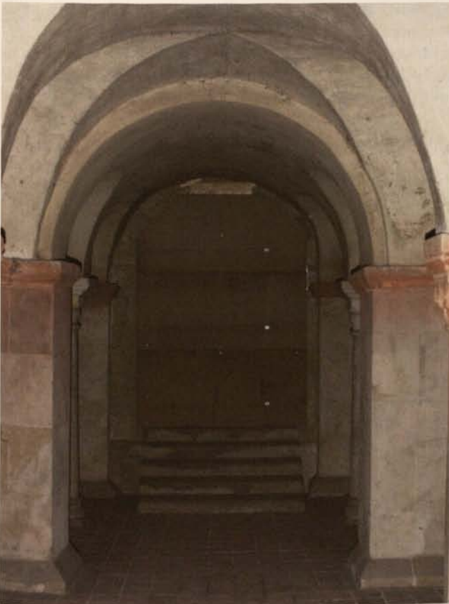
Abb. 10a. Quedlinburg, Stiftskirche St. Servatius, Krypta: Schließung des Zugangs.
