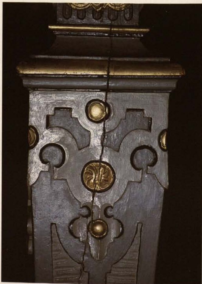
Abb. 15. Esslingen, St. Dionys, Hochaltar, Detail: Nach einer Aufheizung des Kirchenraums auf über 35° sind an der Ausstattung Schäden in Millionenhöhe entstanden.
