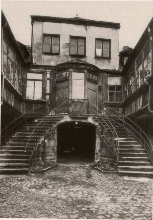
Abb. 2. Nürnberg, Johannisstraße 19, Südfassade vor der Instandsetzung (1997).
