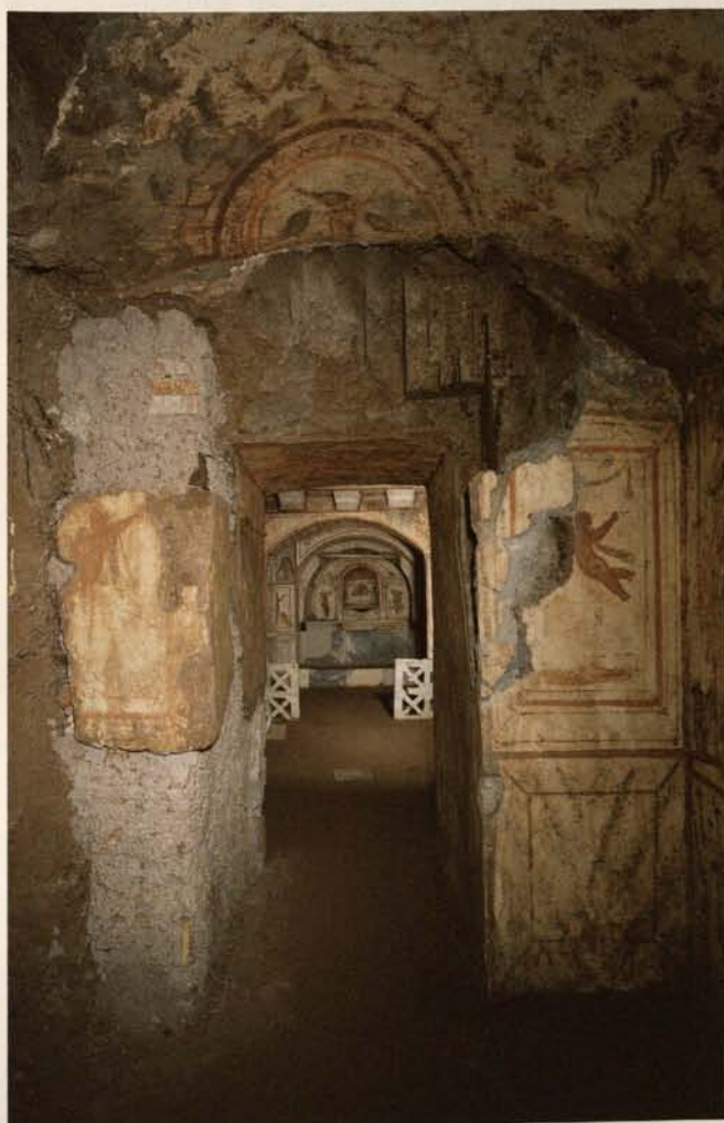
Fig. 8a. Roma, ipogeo anonimo di via D. Compagni, cubicolo M, stuccature in malta cementizia eseguite successivamente al momento della scoperta dell'ipogeo nel 1955 / Rom, Hypogäum an der Via D. Compagni, Kammer M, Putzergänzungen mit zementhaltigen Mörteln aus der Zeit der Auffindung 1955 (2000).
