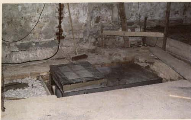
Abb. 17. Einbau einer im Boden versenkten Wärmestation: nach Abschluss der Bauarbeiten bleibt nur noch die Gitterfläche mit etwa einem Drittel der Gerätegrundfläche sichtbar.
