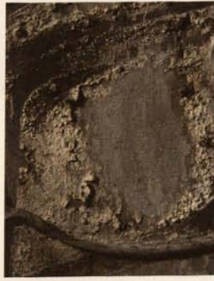
Abb. 9a-b. Nürnberg, St. Sebald, Fenster sVI (Behaim-Fenster), Details mit Schadensbild der sog. „Häutchenbildung“: schichtartiges Abblättern der originalen Oberfläche (a) und in Verbindung mit Blasenbildung an Oberflächen mit originaler Bemalung (b).
