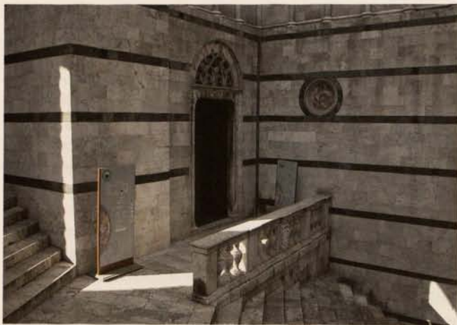
Fig. 1. Siena, cattedrale, ingresso agli ambienti riscoperti sul fianco della chiesa / Kathedrale, Eingang zu den freigelegten Bereichen an der Ostseite der Kirche.
