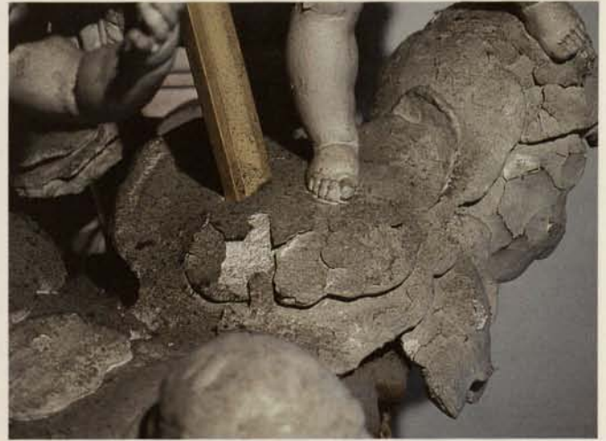
△ Abb. 11. Erbach, St. Martin, Stuckausstattung, Detail: aufstehende Polierweißfassung in einer nur gelegentlich beheizten Kirche.
