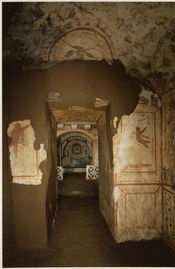
Fig. 8b. Roma, ipogeo anonimo di via D. Compagni, cubicolo M, stuccature a "finto tufo" per riconferire omogeneità alla superficie parietale / Rom, Hypogäum an der Via D. Compagni, Kammer M, Putzergänzungen in Tuffimitation, um den Wandoberflächen wieder eine homogene Struktur zu verleihen (2000).
