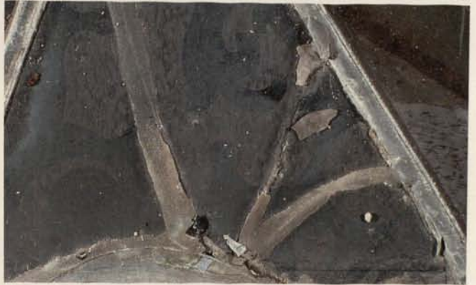
Abb. 6. Köln, Dom, Typologisches Dreikönigs-Fenster, Feld 7a, Detail: gealterter Disbonkleber über Glassprünge (1990).
