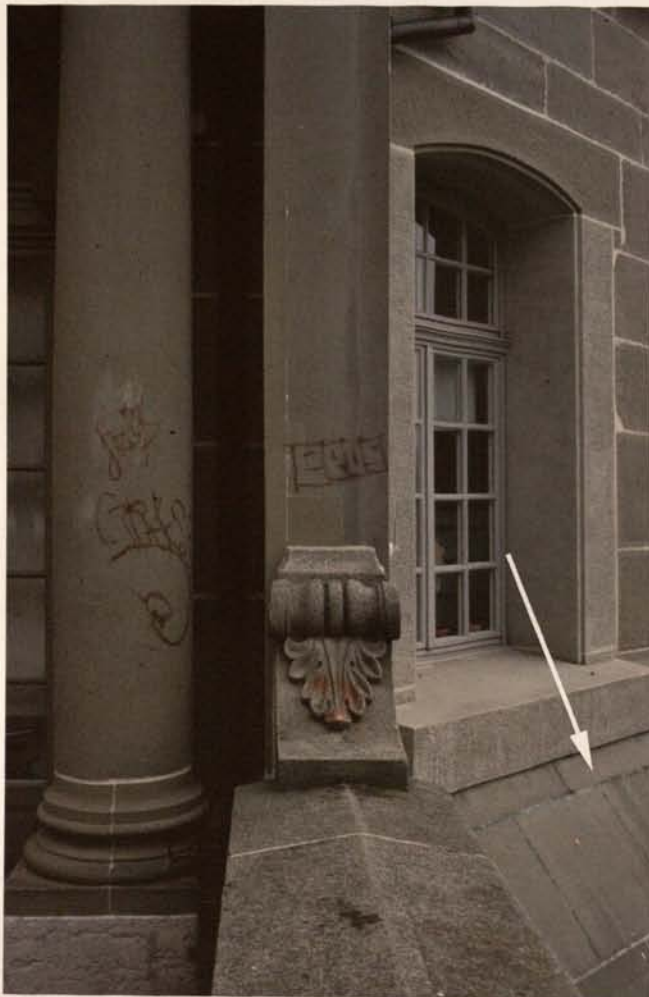
Abb. 11. Bern, Südwestecke der Münsterplattform, Pavillon (13.10.1994): 1987 gefestigte und hydrophobierte Fläche mit ersten Ansätzen einer Verdunkelung durch Bewuchs (Pfeil; vgl. Abb. 12).
