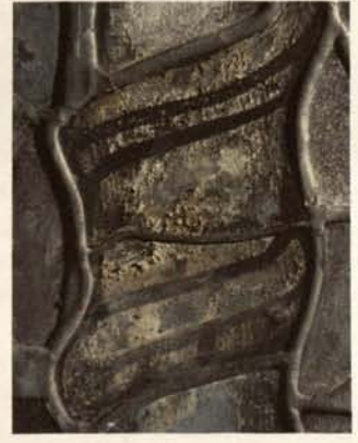
Abb. 9a-b. Nürnberg, St. Sebald, Fenster sVI (Behaim-Fenster), Details mit Schadensbild der sog. „Häutchenbildung“: schichtartiges Abblättern der originalen Oberfläche (a) und in Verbindung mit Blasenbildung an Oberflächen mit originaler Bemalung (b).
