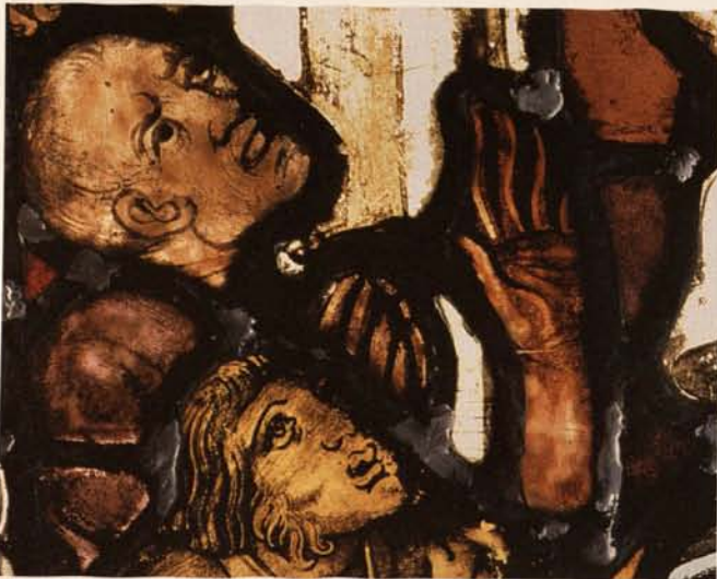
Abb. 10. Ulm, Münster, Westportalfenster, Feld 1f, Detail: miteinander fest verbundene Farbreste und Verschmutzungen auf der Glasoberfläche (2003).
