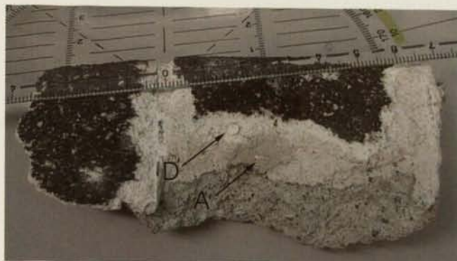
Abb. 10. Versuch mit einem Wassertropfen auf einer Verputzprobe: die äußerste, einige mm starke Putzlage ist hydrophob (der Tropfen bleibt stehen: Pfeil D), sowohl auf der darunter liegenden Putzschicht als auch in der dunklen Oberfläche dagegen rasche Wasseraufnahme (feuchte Stelle bei Pfeil A).
