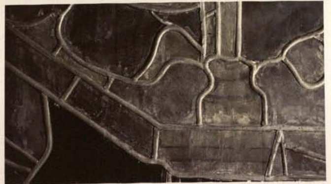
Abb. 5. Nürnberg, St. Sebald, Fenster nVI (Mendel-Fenster), Detail: Kondenswasserabläufe auf der Vorderseite der historischen Verglasung.
