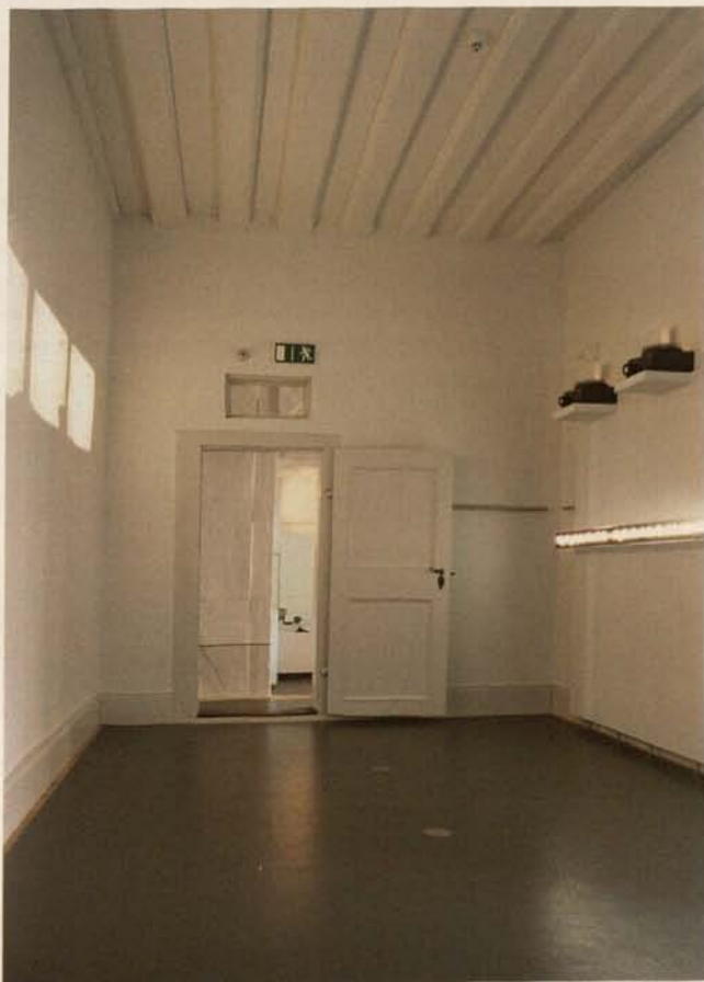
Abb. 16. Fürth, Königstraße 89, erstes Obergeschoss, Raum mit Balken-Bohlen-Decke nach der Instandsetzung und Umnutzung zu musealen Zwecken (1999).
