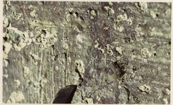
Abb. 14. Quedlinburg, Stiftskirche St. Servatius, Krypta, Wandmalerei: Mikroschollen als Hauptschadensphänomen.
